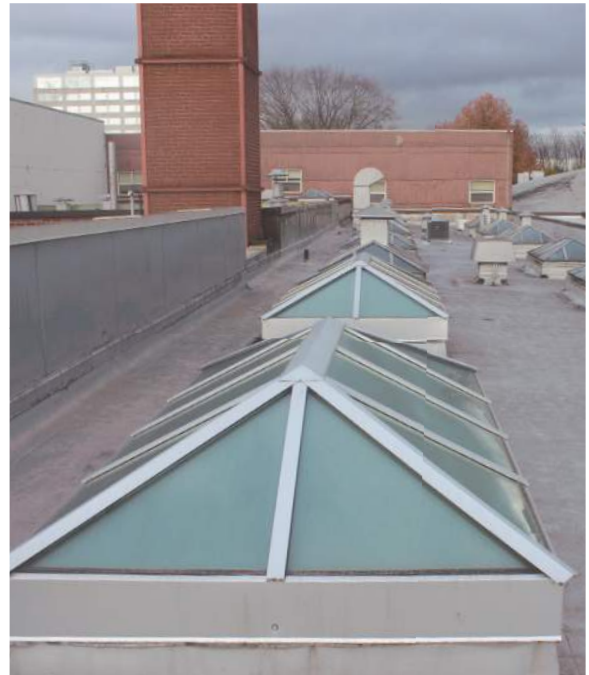
2.4.3/4 Skylights E14 and E15: Aluminum system skylight replacements.
